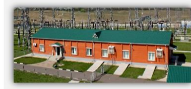
Общеподстанционный пункт управления (ОПУ)
